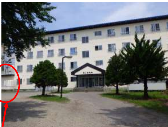
既存ボイラー室
